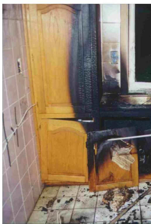
Photo 9 : Empreintes de combustion sur la colonne
